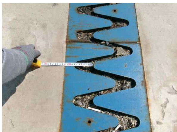
신축이음 이동량 측정
