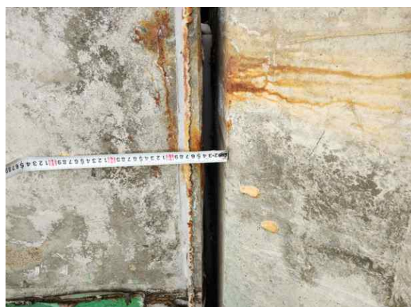
바닥판하면 이동량 측정
